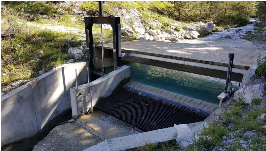
Exemple de la prise d'eau de Bouchouse
